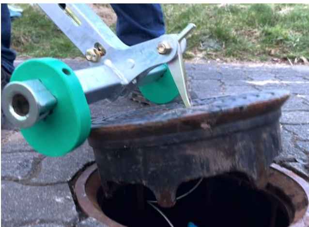
5. ... ausgehoben und zur Seite geschwenkt werden.
