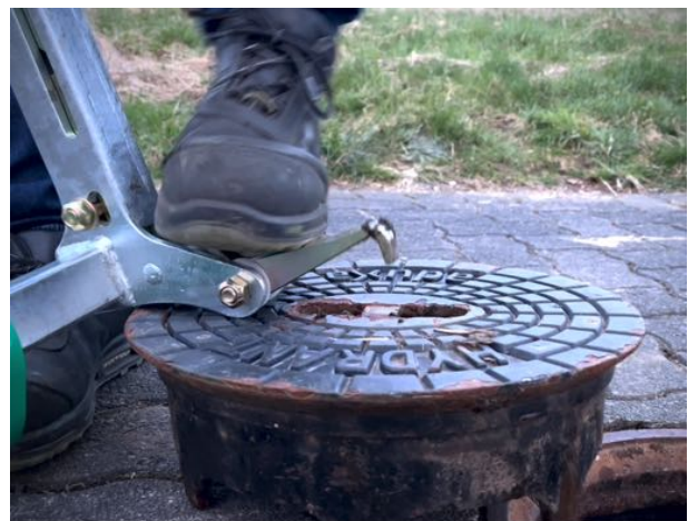
6. Haken wird abschließend per Fuß ausgeklinkt.
